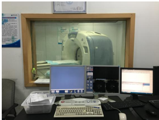
图6-1 门诊楼12号机房操作位、观察窗
